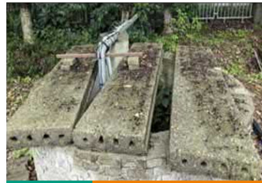
▲井水沖廁所及綠化澆水
